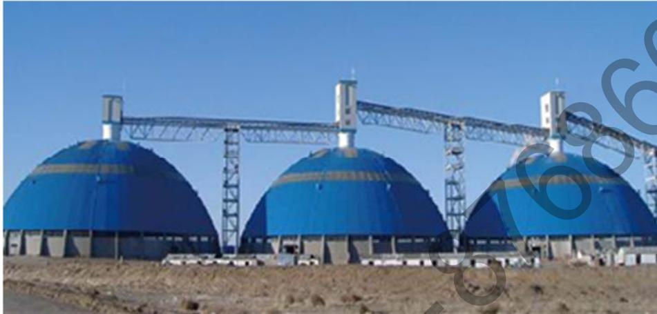
煤场的出现很好地解决了常规敞开式条形煤场堆取料机作业时所产生的大量扬尘对周边环境造成大范围污染的问题，具备储煤量大、占地面积小、场地利用率高、安全可靠性强、环保效益好等优点。同时由于空间封闭、储煤周转速率不可控、散热不便、选煤煤质较杂等原因，煤场也存在严重的煤堆自燃现象。煤堆自燃最直接的影响是烧毁储煤财产、浪费资源；其次自燃产生大量酸性氧化物有害气体，危害现场工作人员人身安全，也会对整个厂区造成二次空气污染；煤自燃挥发出易燃气体，遇到洒水时会产生大量水煤气引发爆燃，危害极大。通过对煤场温度进行监测，可及早发现煤堆自燃隐患，是保证煤场安全运行的有效手段。
